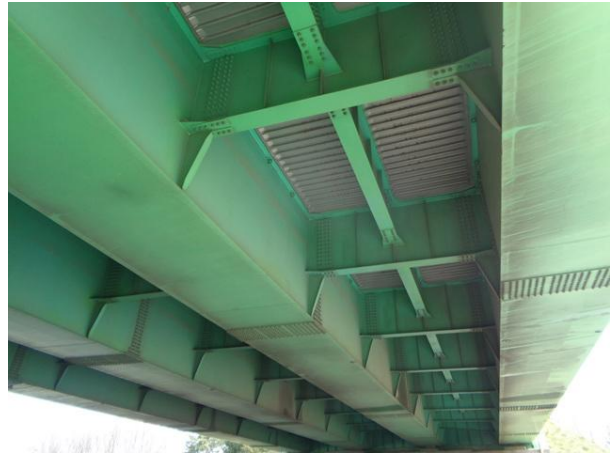
바닥판, 거더외부 전경
